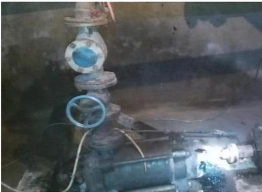
图 2-5 轴承无防护罩，密封损坏
