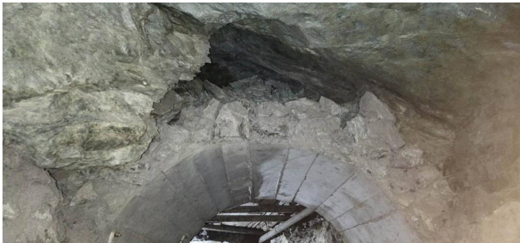
图 2-3 砌碛支护后，未将顶、帮空隙填实
